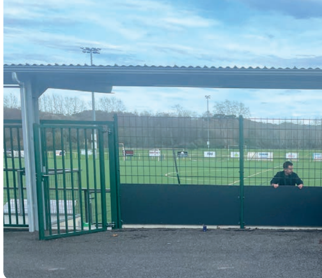
Pose de protections aux gradins du stade Etxeparea par le services bâtiments
